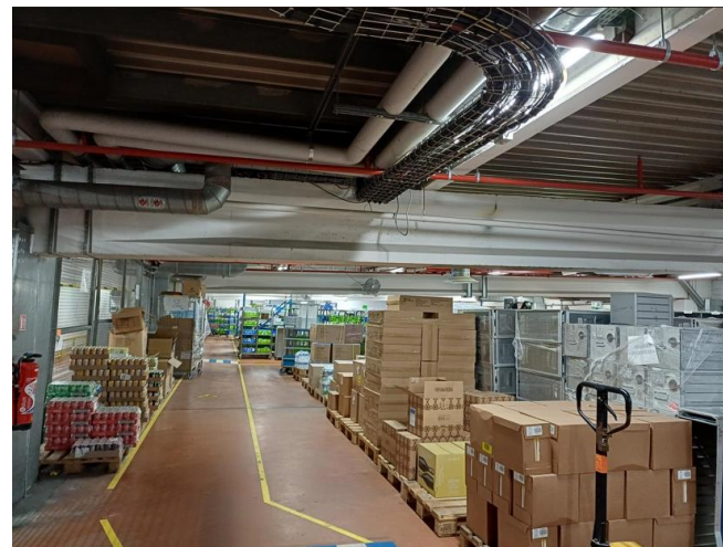
Zone concernée avant travaux
